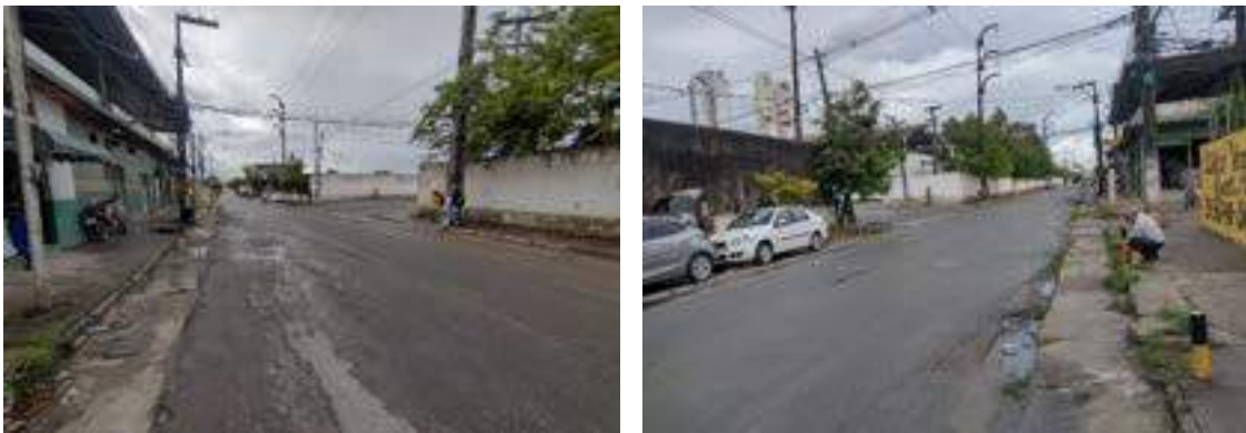
Figura 50 - Vistas do ponto P2 de contagem de tráfego – Rua Vasco Rodrigues x Av. Transamazônica. Fonte: ONE, 2023.
