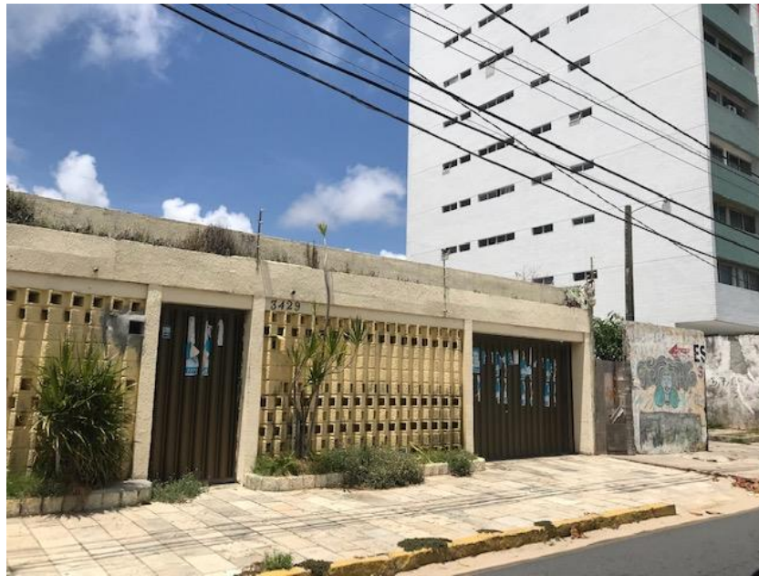
Figura 11 - Muro de uma das edificações atuais do lote 15 C na Av. Min. Marcos Freire Fonte: GR Projetos – Novembro/2018
