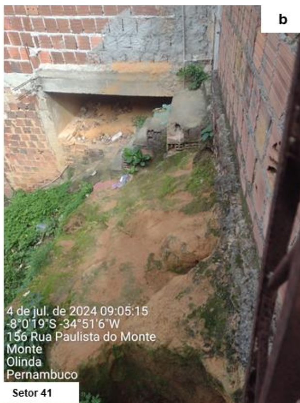
Figura 33: Fotos de campo do setor 41 - a: muro embarrigado; b: encosta com solo exposto; c: presença de lixo e entulho.
