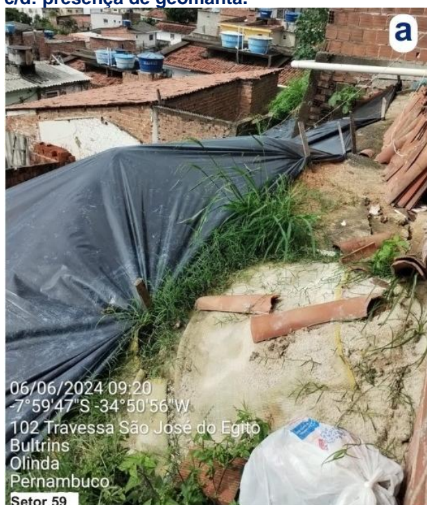
Figura 49: Fotos de campo do setor 59 – a/b: presença de lona plástica em área declivosa do setor; c/d: presença de geomanta.
