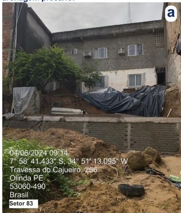
Figura 60: Fotos de campo do Setor 83 – a: pequeno deslizamento e presença de lona plástica; b: moradia próxima ao topo da encosta; c: muro de contenção e área impermeabilizada; d: sistema de drenagem precário.
