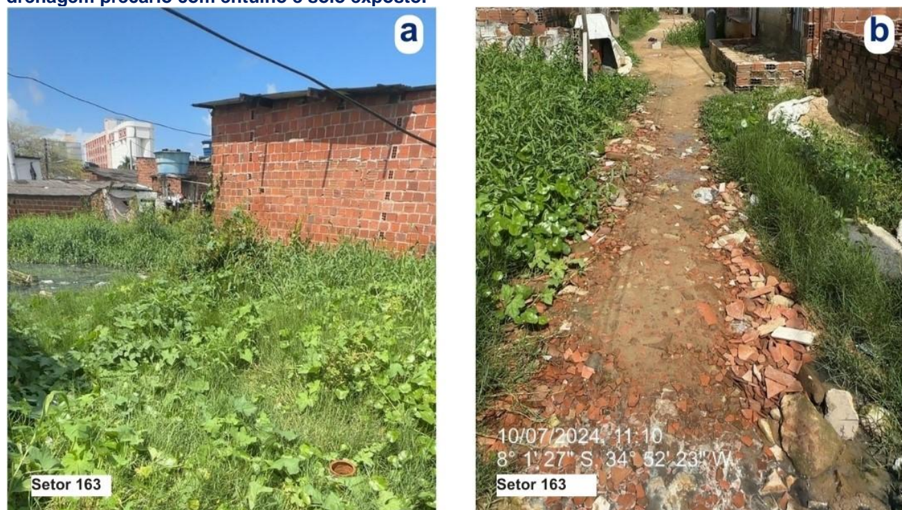
Figura 120: Fotos de campo do Setor 163 - a: vegetação rasteira em área alagada; b: sistema de drenagem precário com entulho e solo exposto.
