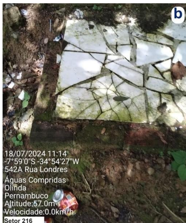
Figura 150: Fotos de campo do Setor 216 – a: sistema de drenagem precário com solo exposto e lançamento de água servida; b: detalhe de fossa séptica; c: vegetação de grande porte em encosta declivosa e presença de solo exposto.
