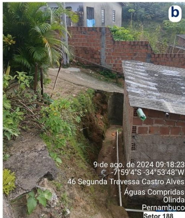
Figura 135: Fotos de campo do Setor 188 – a: moradia próxima à base da encosta com vegetação; b: solo exposto e sinais de deslizamento; c: bananeira e solo exposto em encosta declivosa; d: moradias próximas ao topo da encosta com risco de queda.
