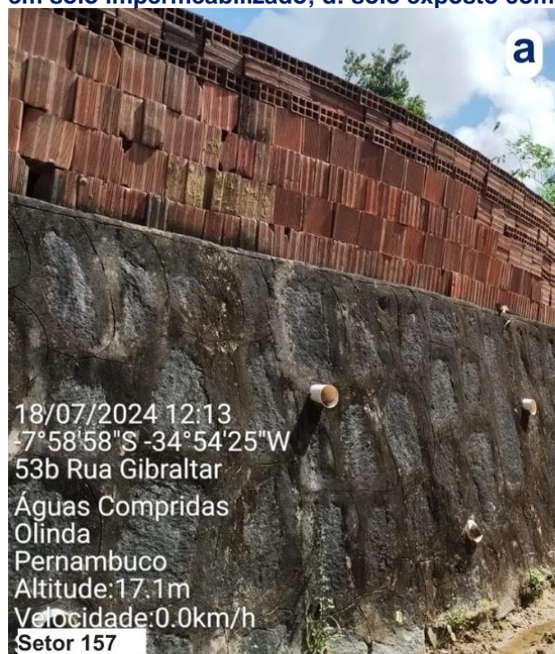
Figura 115: Fotos de campo do Setor 157 – a: muro de contenção; b: presença de lona plástica; c: trinca em solo impermeabilizado; d: solo exposto com vegetação rasteira.
