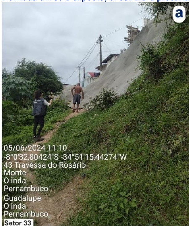
Figura 28: Fotos de campo do setor 33 - a: presença de geomanta em encosta declivosa; b: área inclinada em solo exposto; c: estrutura precária; d: presença de geomanta.
