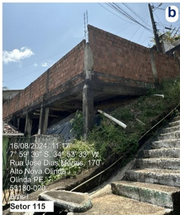
Figura 87: Fotos de campo do Setor 115 – a: visão geral do setor; b: estrutura elevada em moradia com risco estrutural; c: escadaria de concreto próximo a vegetação rasteira; d: ocupação em área declivosa com estruturas precárias.
