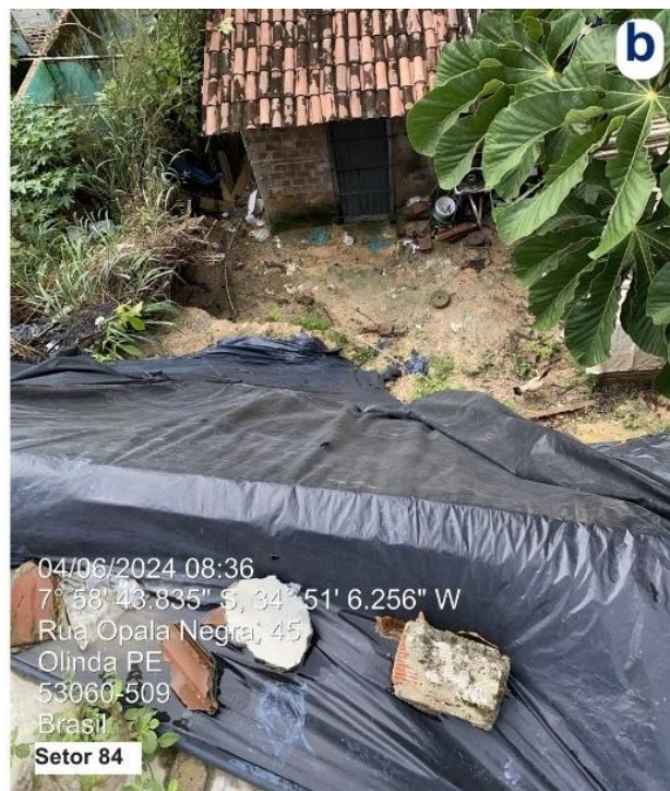
Figura 62: Fotos de campo do Setor 84 – a/b: presença de lona plástica e lançamento de água servida diretamente na encosta; c: encosta declivosa com presença de vegetação de grande porte e rasteira; d: moradias próximas à base da encosta.
