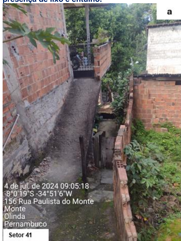
Figura 33: Fotos de campo do setor 41 - a: muro embarrigado; b: encosta com solo exposto; c: presença de lixo e entulho.
