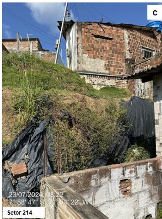
Figura 144: Fotos de campo do Setor 214 – a: solo exposto coberto com lona plástica; b: moradias próximas ao topo da encosta; c/d: detalhe de lançamento de água servida.
