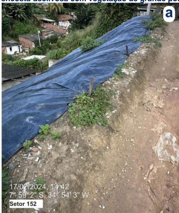
Figura 110: Fotos de campo do Setor 152 – a/b: presença de lona plástica cobrindo encosta; c/d: encosta declivosa com vegetação de grande porte, sobretudo, bananeiras.
