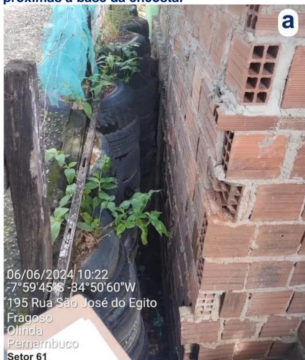
Figura 55: Fotos de campo do Setor 61 - a: estrutura de contenção improvisada; b/c: moradias próximas à base da encosta.
