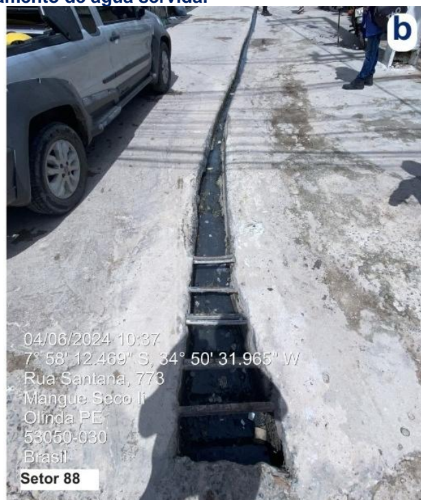
Figura 72: Fotos de campo do Setor 88 – a/b: sistema de drenagem precário; c: presença de lixo e entulho; d: sistema de drenagem precário com lançamento de água servida.
