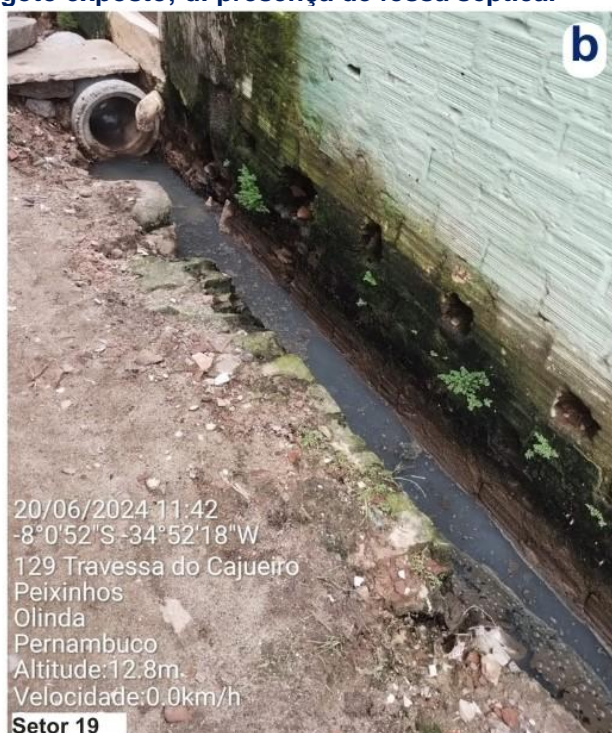
Figura 14: Fotos de campo do setor 19 – a: sistema de drenagem com resíduos em frente à moradia; b: esgoto a céu aberto; c: passagem estreita com esgoto exposto; d: presença de fossa séptica.
