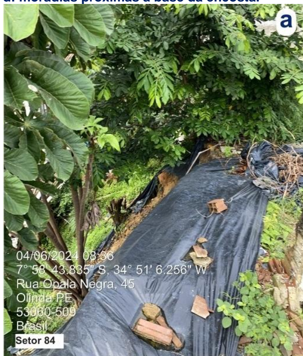
Figura 62: Fotos de campo do Setor 84 – a/b: presença de lona plástica e lançamento de água servida diretamente na encosta; c: encosta declivosa com presença de vegetação de grande porte e rasteira; d: moradias próximas à base da encosta.
